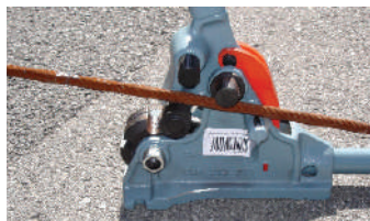
Positionnement du fer à béton pour cintrer.
