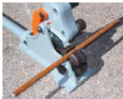
Positionnement du fer à béton avant la coupe.
